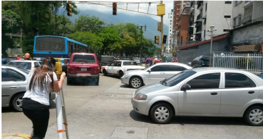
Fig. 36. Medición de los puntos de detalle con la Estación Total. Fuente: Elaboración propia.
